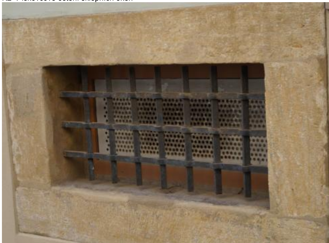
K2- Pískovcové ostění sklepních oken
