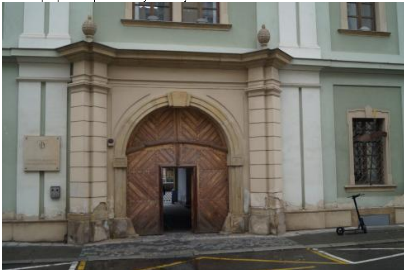
K8 - Pískovcové bosované nároží při levém nároží západní fasády a pravém nároží severní fasády vč. 1 ks nákolníku
